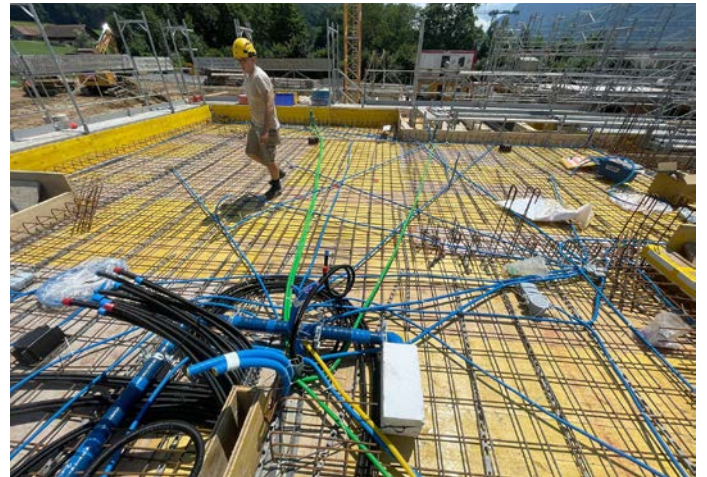
Einlegen der Installationsrohre
