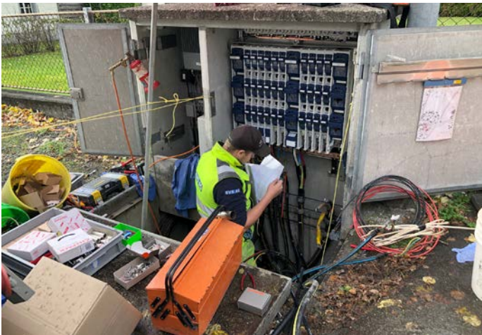
Verteilkabine während Sanierung
